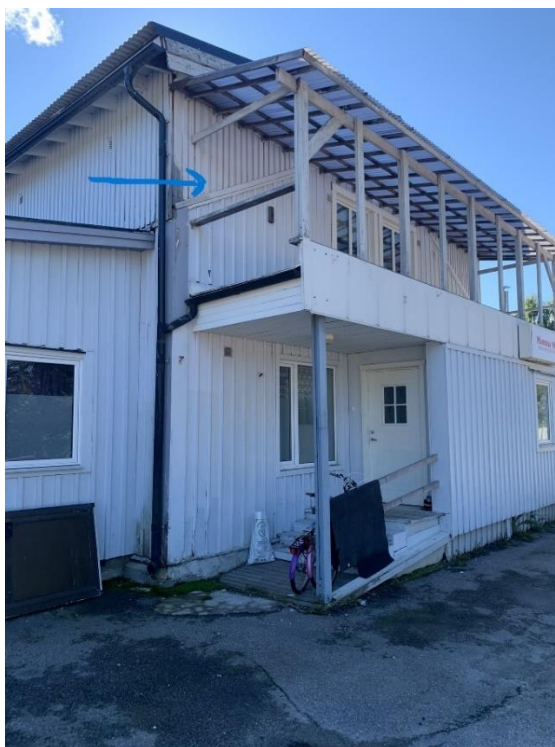
Detalj som visar den ursprungliga takvinkeln. Foto: Katarina Kallings, SvFm.
