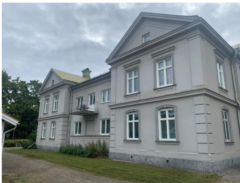
Tingshuset ägs i dag av Björnes bygg som där har 9 hyreslägenheter. Till vänster syns en uppförd förrådsbyggnad, vilken något förtar tingshusets monumentala uttryck. Foto: SvFm
