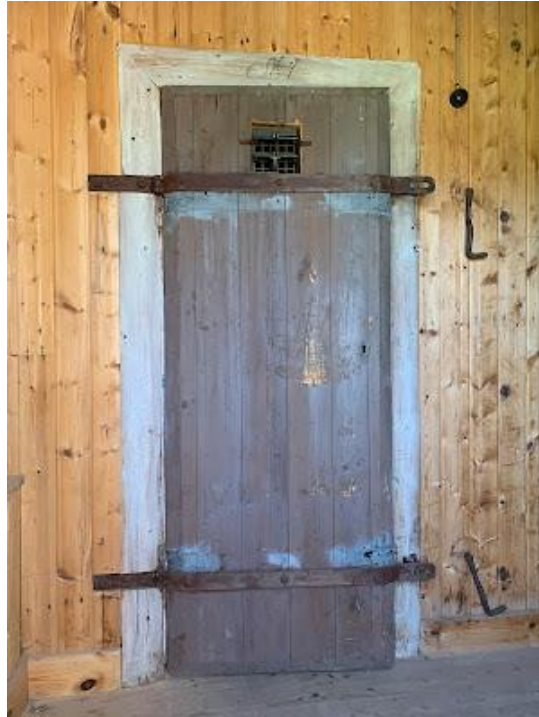
Bevarad celldörr, med titthål och låsbeslag.
