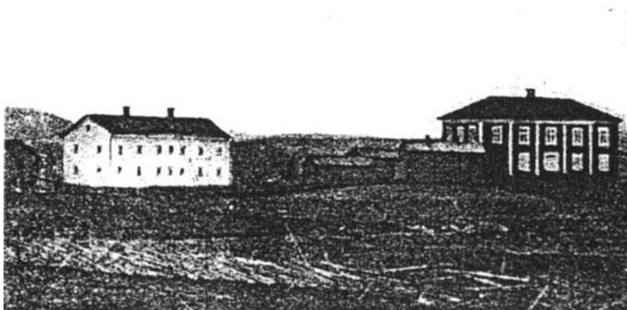
Näsbyns tingshus till höger. Platsen kallas än idag för tingshusbacken. Foto: Dellenportalen.
