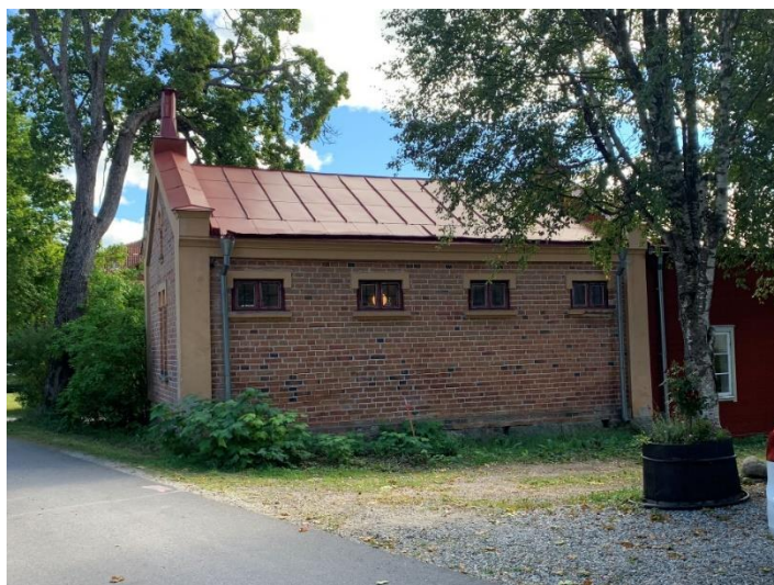
Häktet sett från baksidan med sina cellfönster.
